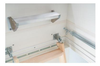
5. Rahmen des Flachdachausstiegs genauso wie die Zwischenrahmen montieren.
