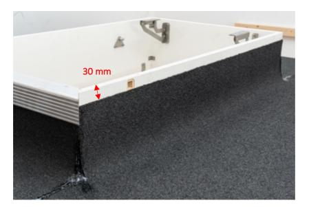
8. Die Aluminiumabdeckungen mit den beiliegenden Spenglerschrauben auf dem Kasten verschrauben.
