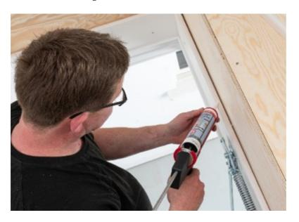
**3.** Das zum Lieferumfang gehörende H-Profil auf die oberen Kanten des Lukenkastens aufstecken und Montagekleber auf das H-Profilaufbringen.
