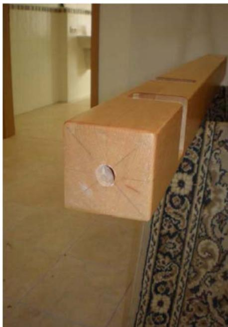
24. Hülse bis auf Rohbeton einsetzen
