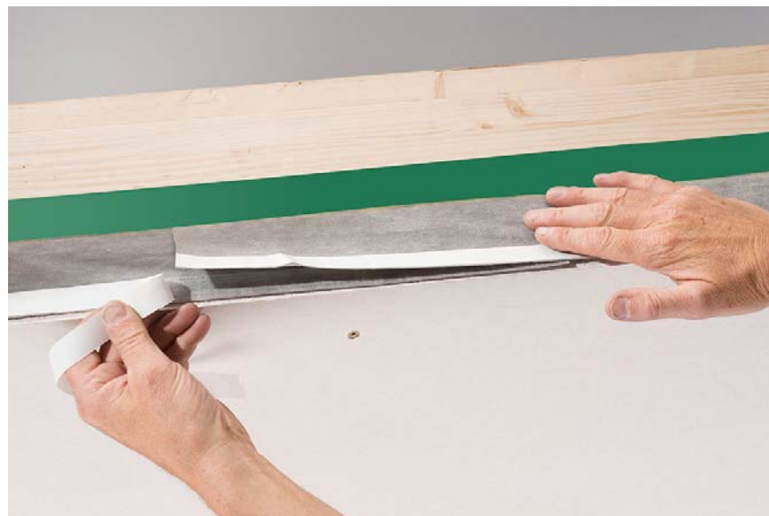
DOLLE Deckenanschlussband, die Enden 10 bis 15 cm überlappend, verkleben
