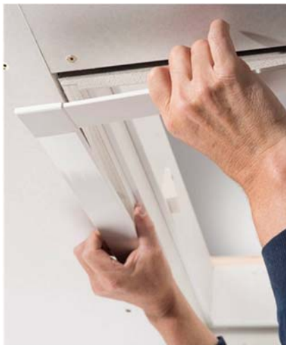
Abdeckleisten montieren.
