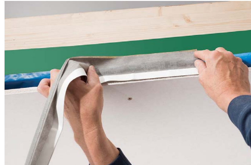
DOLLE Deckenanschlussband umlaufend, deckenbündig verkleben
